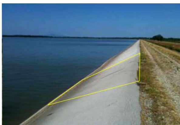
Slika 1.3-5: Položaj sifona na unutrašnjoj strani nasipa
