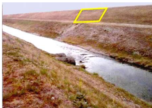
Slika 1.3-6: Položaj sifona na vanjskoj strani nasipa
